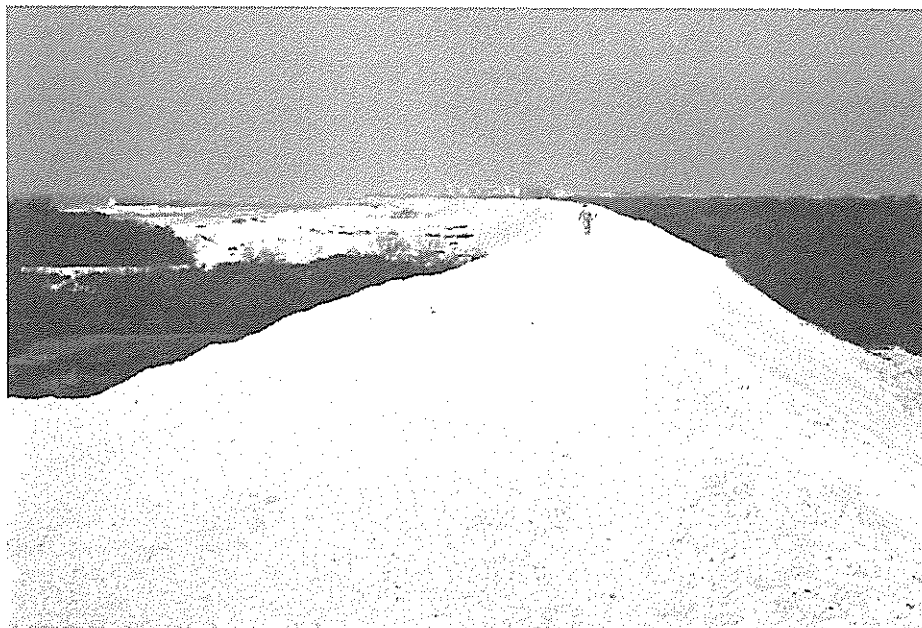
Fig. 13 – Areão, a sul da Praia da Vagueira. Mais uma tentativa (uma «muralha» de areia = dique) para evitar que os galgamentos do mar atinjam a laguna de Aveiro. Data 13.2.2001
