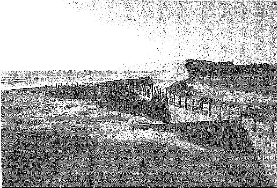
Fig. 12 – Praia do Belinho (Esposende). Estrutura para tentar neutralizar um galgamento do mar. A sua extremidade norte foi destruída quase totalmente durante os últimos temporais. A dinâmica do galgamento levou as águas do mar a invadirem os campos agrícolas. Data 8.5.2001
