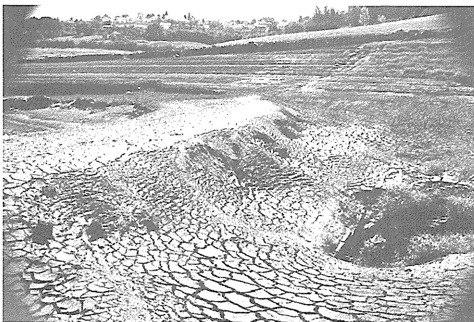
Fig. 7 – Barragem da Venda Nova (Vieira do Minho), a jusante da povoação. Antigo caminho, coberto pelos sedimentos finos do enchimento que apresentam fendas de dissecação. Data 9.8.2001
